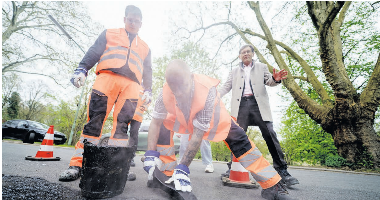
Oberbürgermeister Dr. Frank Dudda begutachtet eine Ausbesserungsmaßnahme.
